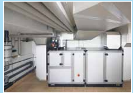
Auf die Klimatisierung hochwertiger Schwimmhallen ist die Firma Herget spezialisiert. Von Beginn an sind die Geräte auch mit Wärmerückgewinnungssystemen ausgestattet.
